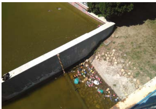
Basura y agua sucia en el estanque del Parque de Andalucía
