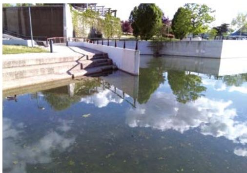
Estanque del parque de las cascadas, en Vaidelasfuentes
