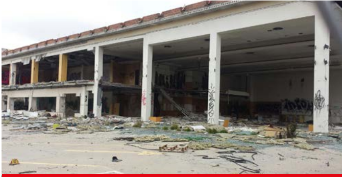
Edificio abandonado en el polígono industrial.
